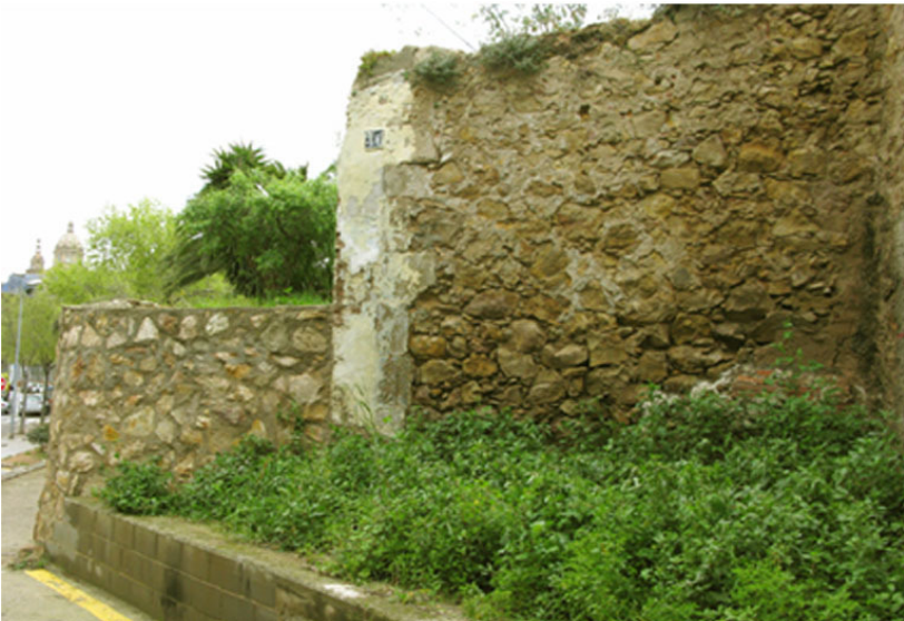
Fotos de las zonas del barrio dibujadas en los lienzos durante las demoliciones (año 2002)
