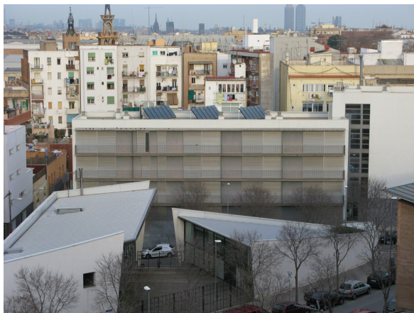
Piso de protección oficial frente al cerro para realojar los expropiados de la segunda fase.
